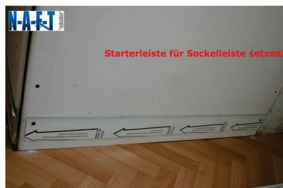
Starterleiste setzen, Sockelleiste einklicken!
